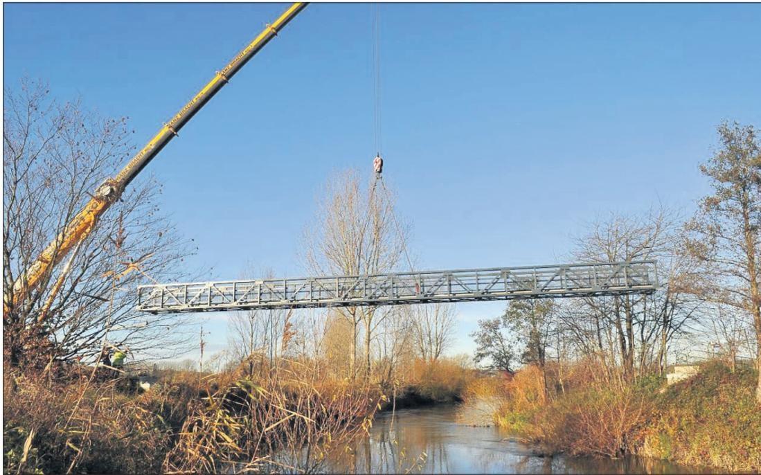
Ende August wurde der „Lippestege“ zwischen Hörste und Mettinghausen entfernt und saniert. Nun wurde er mit Hilfe eines mobilen Krans an seinen Ursprungsort zurückgebracht. Allerdings bleibt er voraussichtlich bis Anfang Dezember noch gesperrt. Foto: Sanimir Osmic
